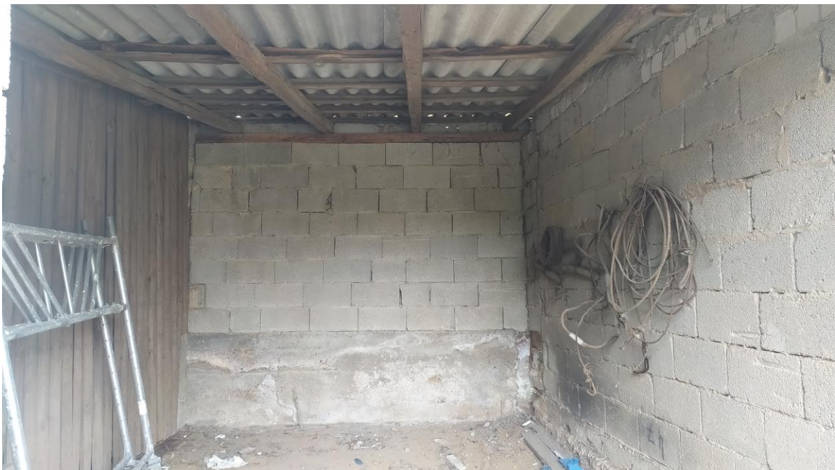
Abbildung 11: Innenraum der Garage mit Potential für Vögel und Fledermäuse.
