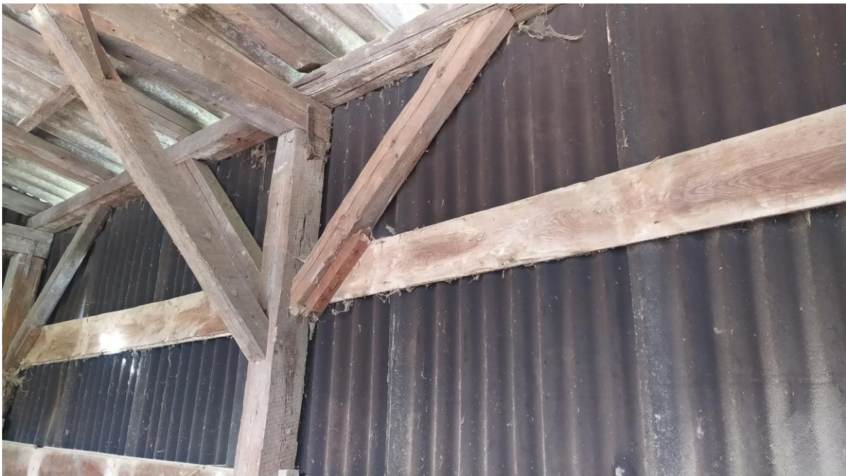
Abbildung 9: Gebälk der Garage.
